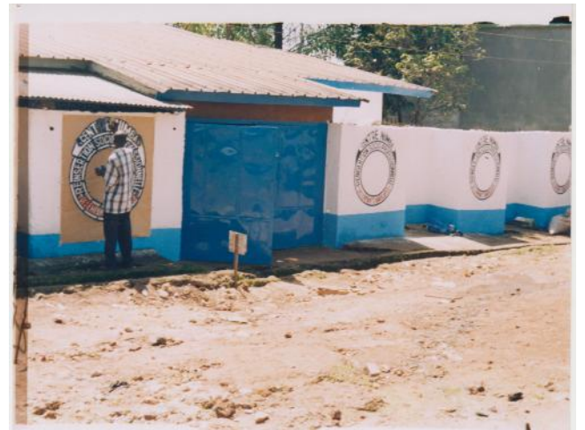
En nu de weg nog asfalteren !
